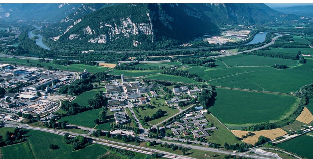
Am Rande der französischen Alpen ist das Constellium Technology Center angesiedelt (untere Bildmitte)
