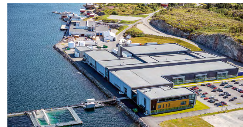
Im Fokus der Aktivitäten von AM North stehen die Fischindustrie sowie die Öl- und Gasförderung (rechts das Ölförderungsschiff Johann Castberg)
